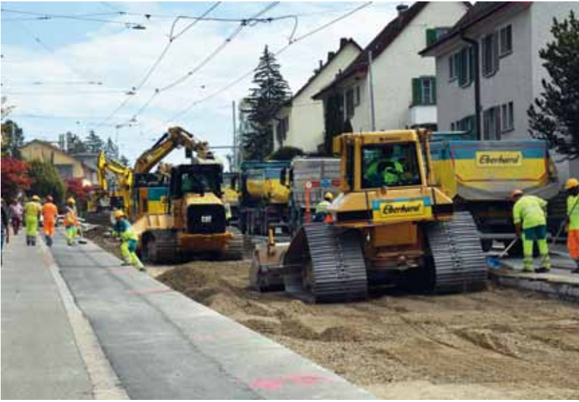
Mithilfe der Cat D5K2 und dem D6N Dozer wurde ein neues Planum erstellt. Foto: Eberhard
