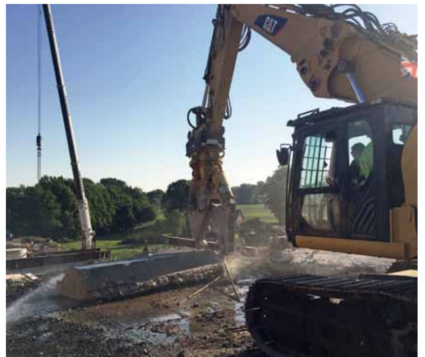
Die Dütebrücke über die A1 wurde in zwei Hälften geschnitten.
